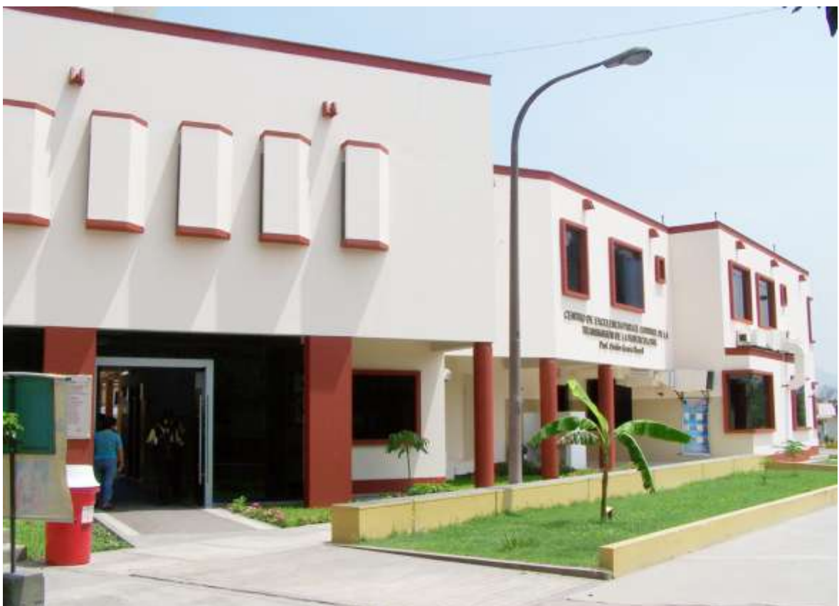
Centro de Excelencia para el Control de la Tuberculosis del I Hospital Nac. Hipólito Unanue
