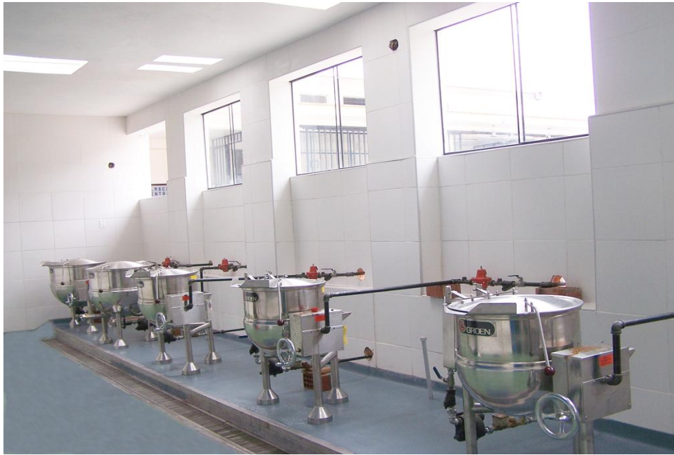
Mejora de la infraestructura, sistema de vapor y marmitas del Servicio de Preparaciones Especiales
