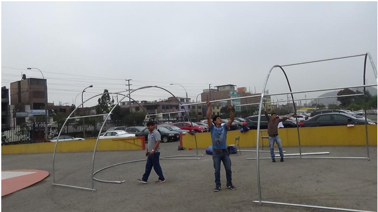
Estructura tubular y en bloque permite un armado fácil y rápido, necesario en casos de desastres naturales.
