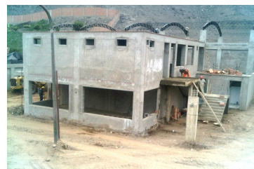
Proyecto Planta de tratamiento de RSH octubre del 2011
